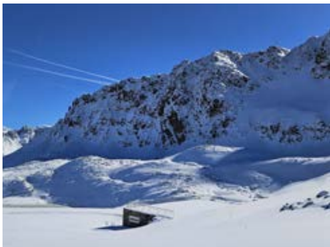
Intégration dans la pente de la salle des machines de la Loze 📍 Jordan FERMAUT, S3V
